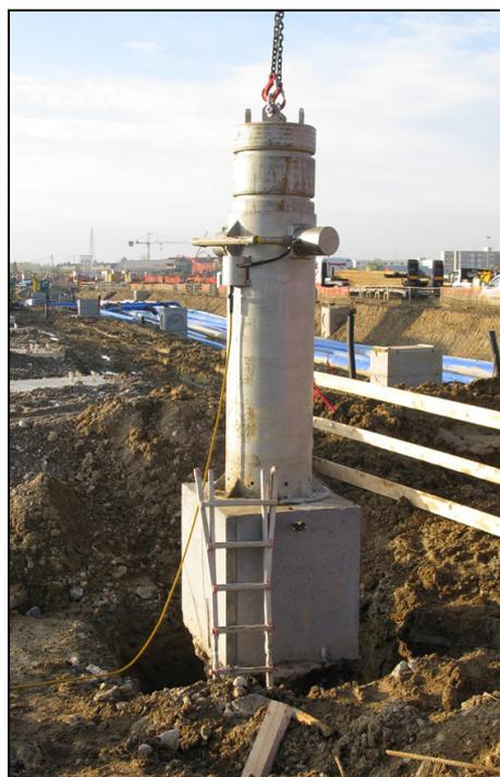
Figura 3: dado realizzato sulla testa del palo sopra il quale viene poggiato e successivamente fissato il maglio.
