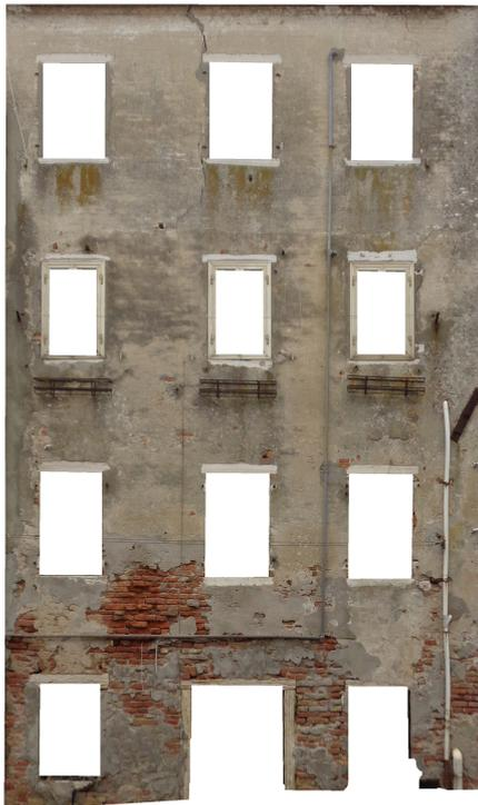
Fig.5. Ortofoto della facciata ottenuta proiettando sulla mesh una foto dell'edificio. In alto al centro è visibile la porzione di lesione presa in esame.
