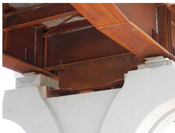
Figura 22: esempio posizionamento di miniprismi in appoggio.
