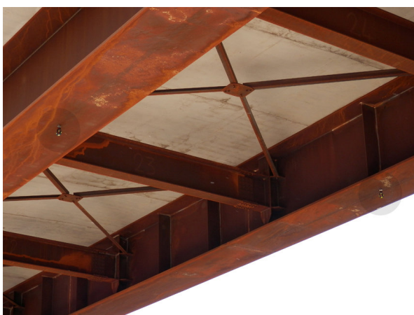
Figura 21: esempio posizionamento di miniprismi in campata.
